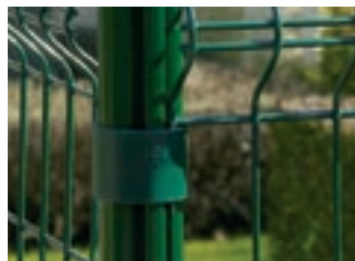
Poteau avec système de fixation à collier
